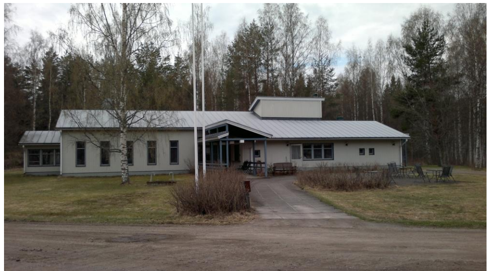
Kuva 7. Päärakennus, jossa sijaitsee lomakylän vastaanotto, kokoustilat, elintarvikekioski ja oleskelutilat.
