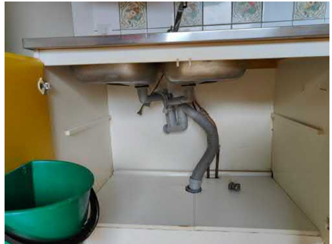
Kuva 74 Allaskaapeissa ei havaittu vuotoja.
