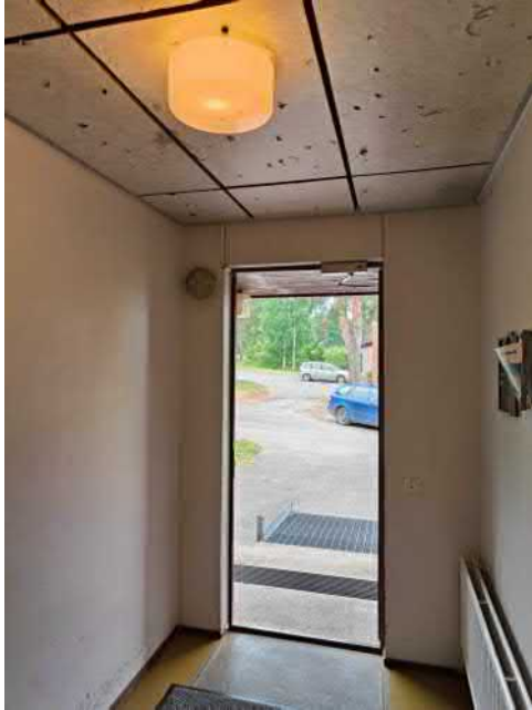
Kuva 9 A rapun porraskäytävää
