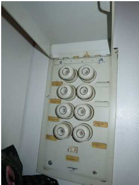
Kuva 85 Ryhmäkeskus, asunto. Alkuperäinen vuodelta 1976, 1-vaihekeskus
