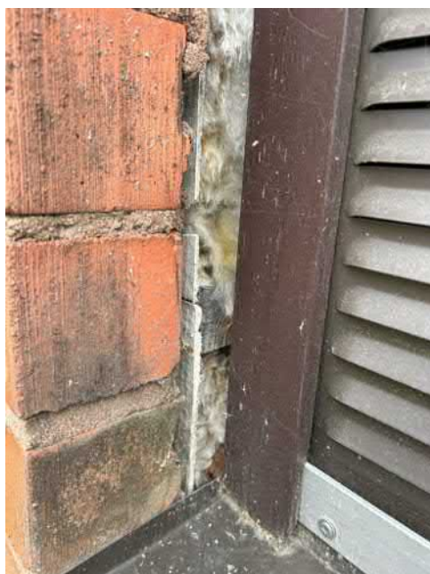
Kuva 20 Ulkoseinämuurauksen taustalla on tuulensuojalevy.
