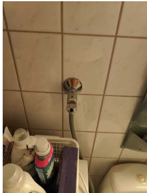
Kuva 70 Vesikalusteita uusittu tarpeen mukaan.
