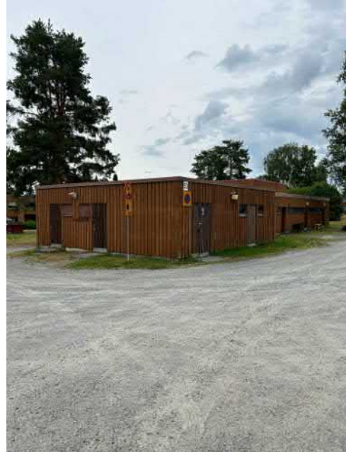
Kuva 2 Maanpinta viettää loivasti parkkipaikalta yhteistilarakennukseen päin ja poispäin rakennuksen vastakkaisella puolella.
