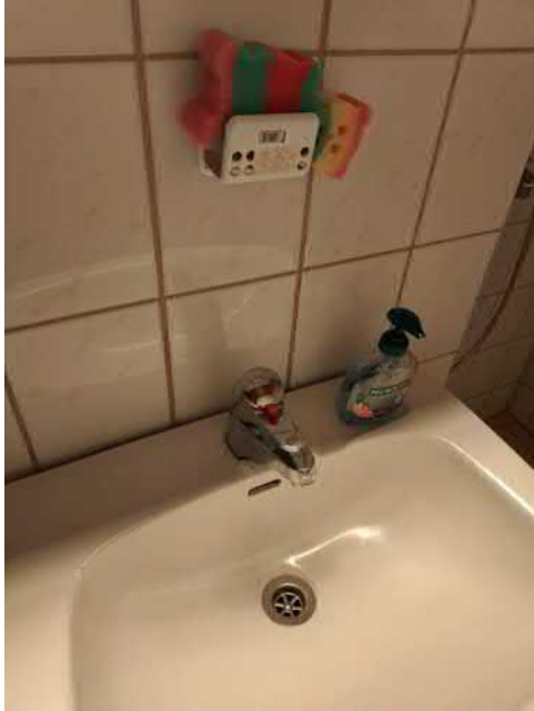
Kuva 71 Vesikalusteita uusittu tarpeen mukaan.
