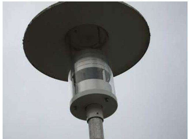
Kuva 94 Pihavalaisin. Elohopeahöyrylamppuvalaisin.
