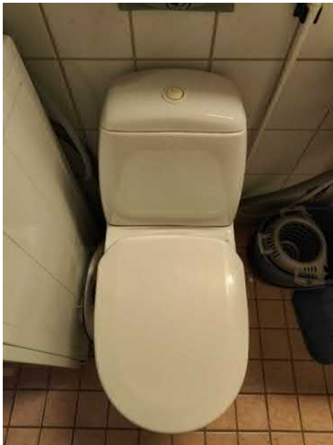
Kuva 69 WC-istuimia uusittu tarpeen mukaan.
