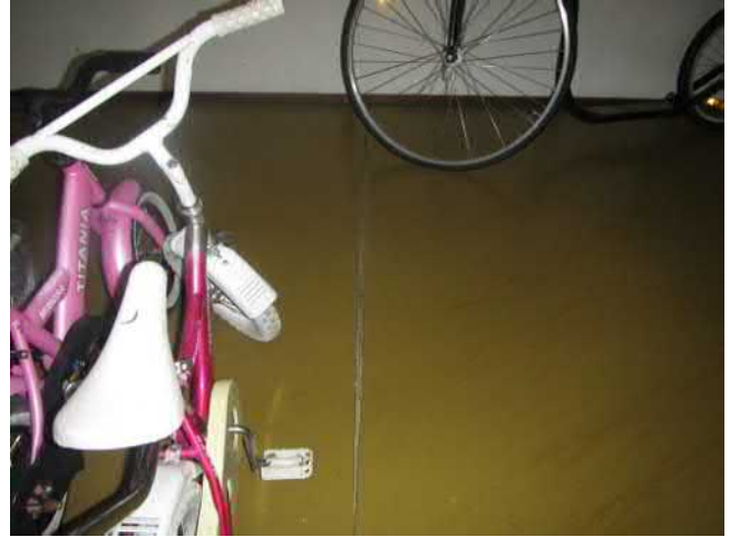
Kuva 10 Muovimaton saumassa on kutistumishalkeama.
