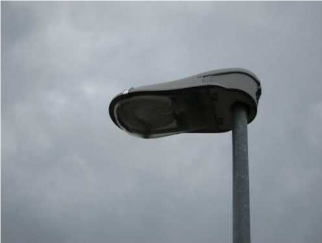
Kuva 95 Pysäköintialueen valaisin. Elohopeahöyrylamppuvalaisin.
