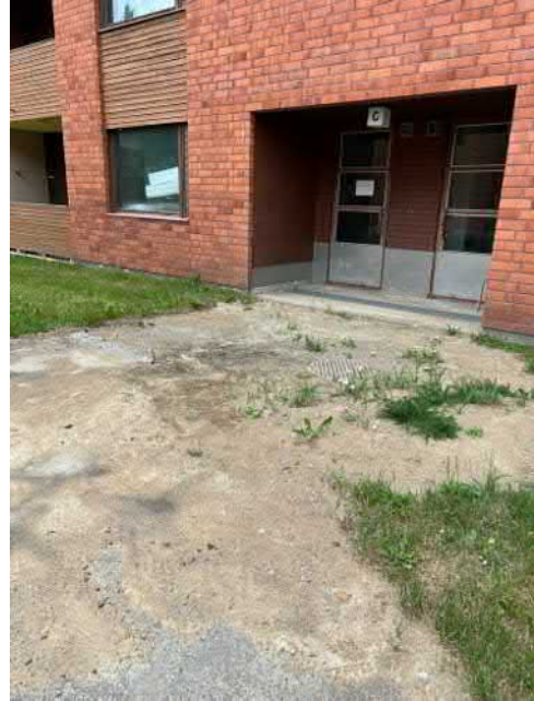
Kuva 6 Sokkelin korkeus vaihtelee ja on paikoitellen erittäin vähäinen.
