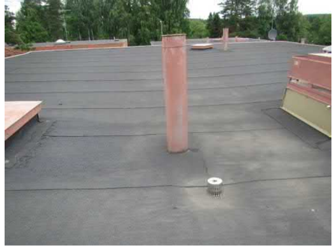
Kuva 39 Kattokaivo.
