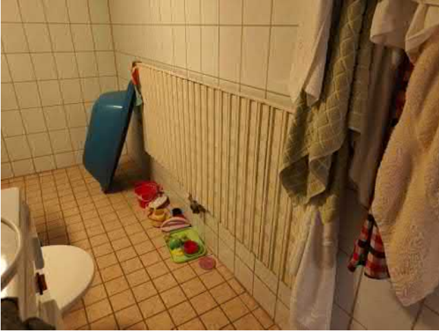
Kuva 75 Asunnoissa todella kuuma. Syyksi epäillään isoja kiertoovesipattereita.
