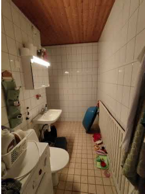
Kuva 81 Poistoventtiilit asunnoissa ns. likaisissa tiloissa.
