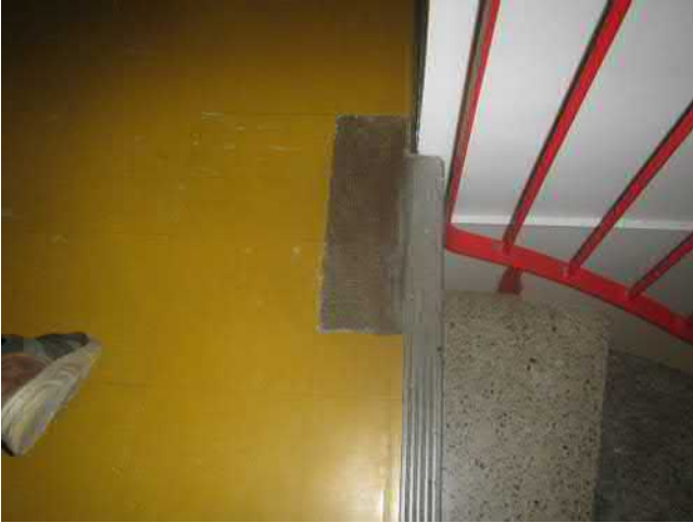
Kuva 55 Porraskäytävien lattioiden pintamateriaalina Flex muovilaatta.
