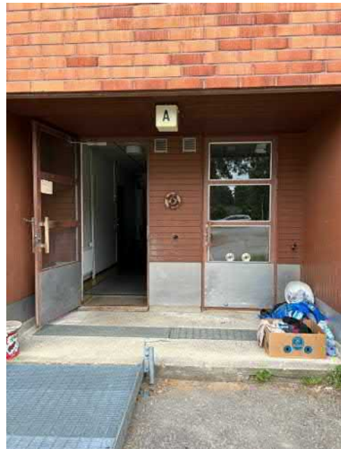
Kuva 31 Porrashuoneen ja varaston ulko-ovet.
