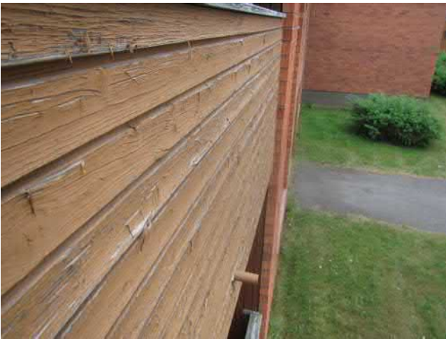
Kuva 33 Parvekkeen etuosan paneeliverhousta.
