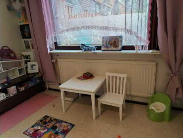
Kuva 67 Yleiskuva huoneistojen patterit. Patterit ja patterirungot alkuperäisiä.
