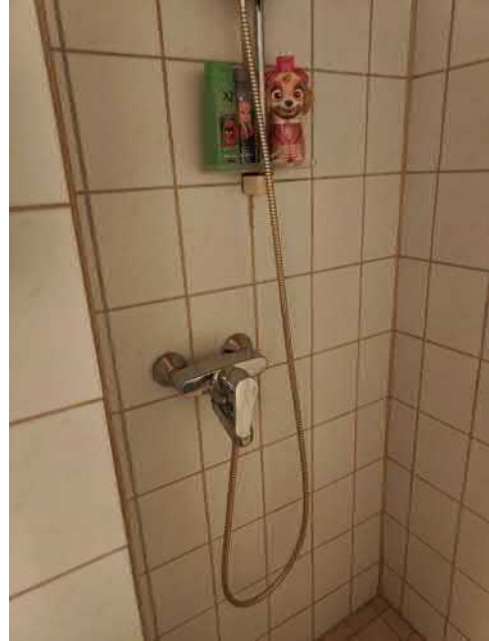
Kuva 72 Vesikalusteita uusittu tarpeen mukaan.
