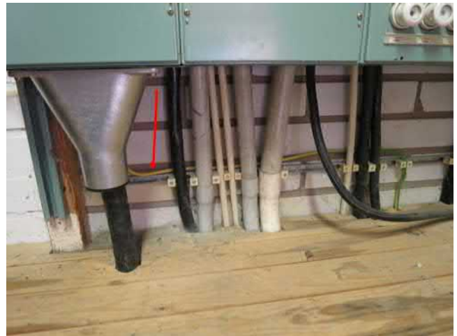
Kuva 86 Pääkeskuksen alalpuolella maadoitusjohdin ilman merkintää
