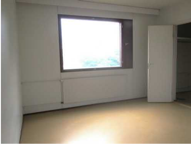
Kuva 47 Makuuhuoneiden pintarakenteet ovat pääosin alkuperäisessä kunnossa.
