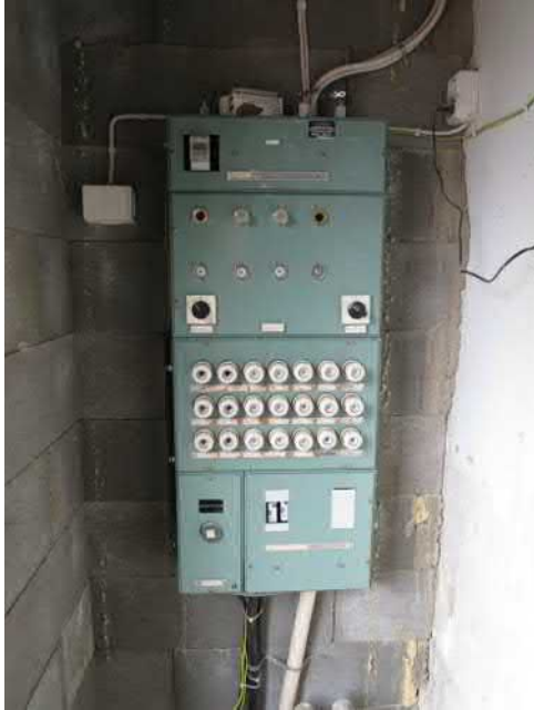
Kuva 41 Kiinteistökeskus, tekninen tila Alkuperäinen vuodelta 1977
