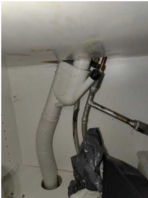
Kuva 32 Allaskaapeissa ei havaittu vuotoja.
