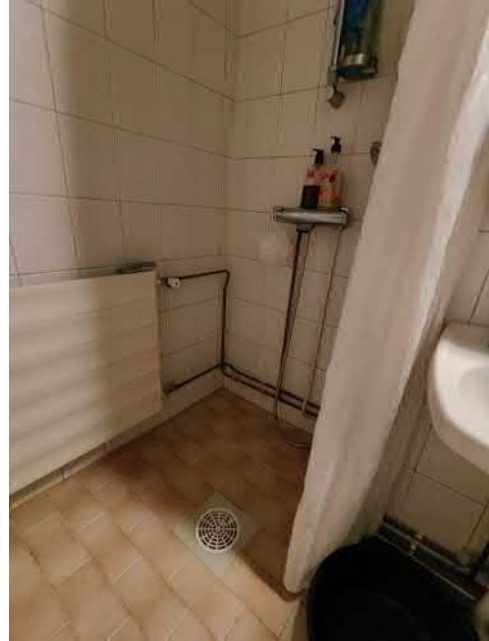
Kuva 31 Asunnoissa todella kuuma. Syyksi epäillään isoja kiertovesipattereita.
