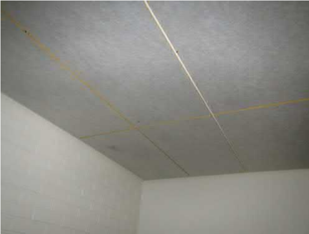
Kuva 23 Akustovillojen reunat ovat villapinnalla.
