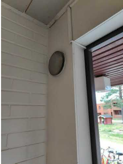
Kuva 39 Porashuoneen korvausilmaventtiili
