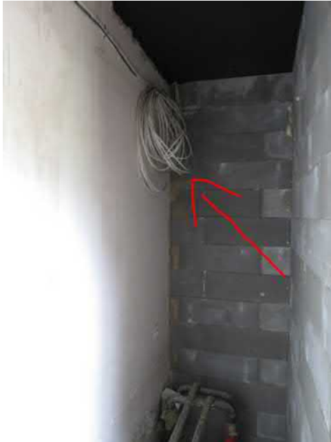
Kuva 48 Sähkökaapeleita roikkuu teknisessä tilassa
