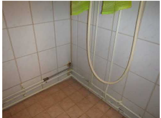
Kuva 38 KytKentäputkia uusittu tarpeen mukaan.
