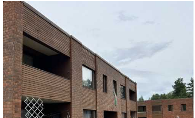
Kuva 15 Parvekkeen etuosan paneeliverhousista.
